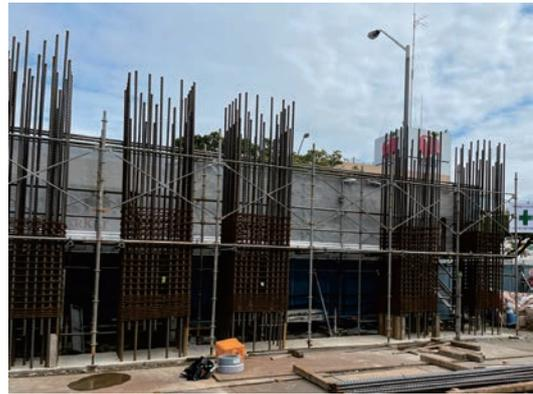
写真-1 柱鉄筋地組ヤード
