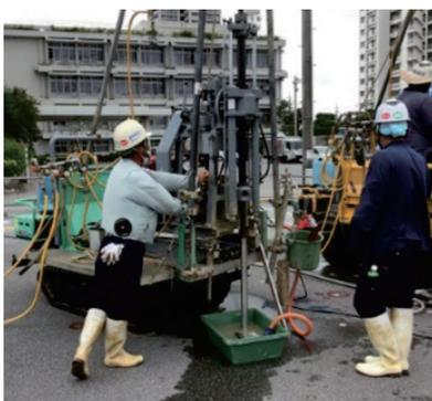
写真-4 鉛直探査状況
