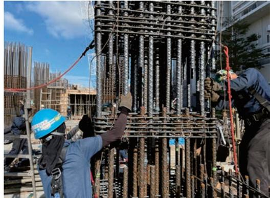
写真-2 地組した柱鉄筋の吊り込み
