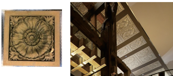
写真-3 特殊加工したティンシーリング
