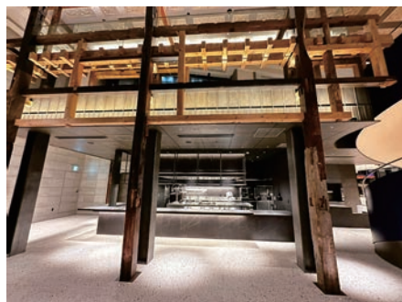
写真-2 古民家再生木材を活用した木フレーム
