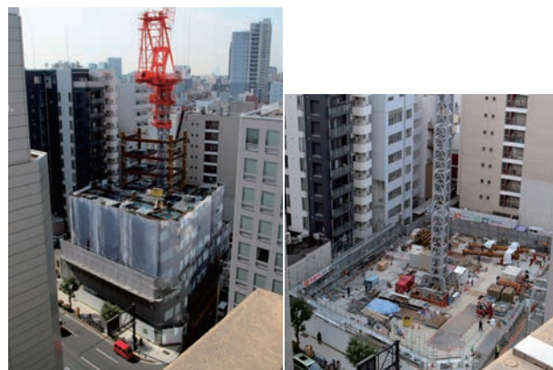
写真-4 クレーン設置状況
