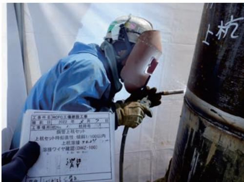
写真-7 横向き継手溶接
