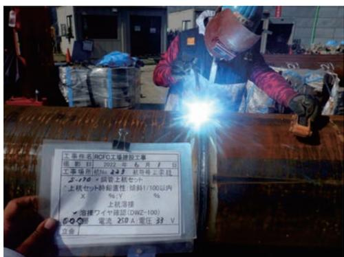
写真-8 地組による下向き継ぎ手溶接
