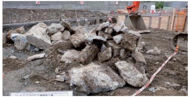
写真-2 掘削時に発生した転石
