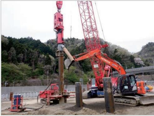
写真-3 拡径式ダウンザホールハンマー工法
