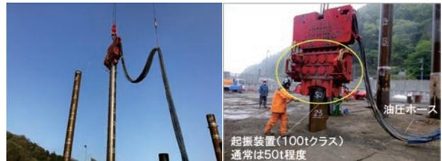
写真-5 パイプロフォンサー工法 (超高周波可変式油圧)
