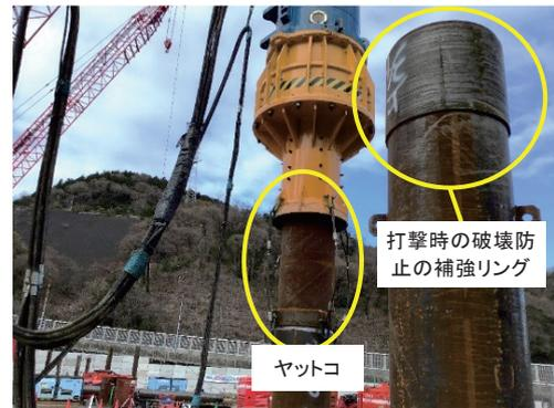
写真-6 フライング油圧ハンマー打撃工法
