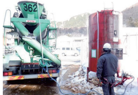
写真-8 耐寒促進剤投入サイロ設置・投入状況
