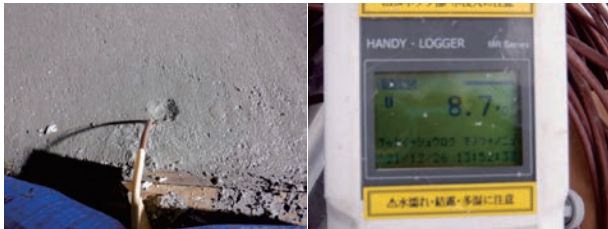
写真-11 コンクリート温度の測定状況
