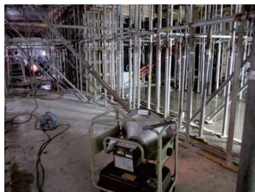
写真-5 ブライツヒーター採暖加温養生状況
