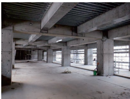
写真-12 寒中コンクリートを施工した 4 階の型枠解体後の状況
