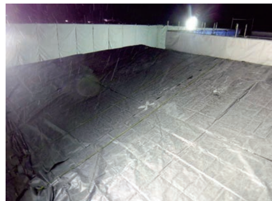
写真-10 保温養生マット敷設・白シート風除け設置状況
