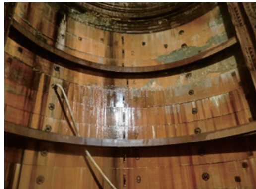
写真-6 FFU ライナープレート組立状況
