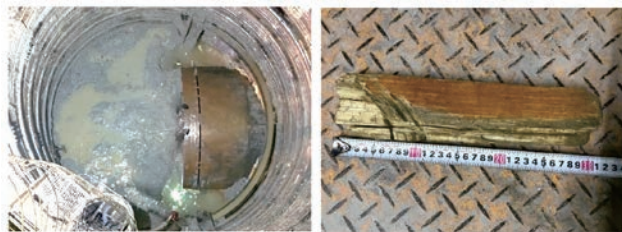
▲シールド機到達状況 ▲FFU切削屑
