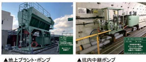
写真-4 クレーショック注入設備
