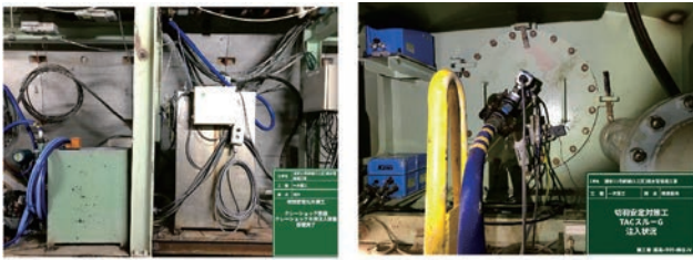
▲TACスルーG注入設備 ▲チャンパー内注入状況
