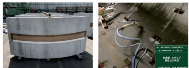
▲Eバッグセグメント ▲Eバッグ注入状況
