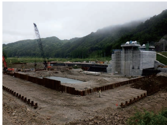
写真-3 仮締切（2期施工）
