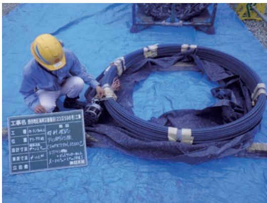
写真-8 エポキシ樹脂被覆PC鋼より線
