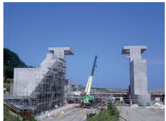
写真-11 カーテンウォール施工前
