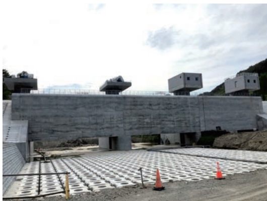
写真-13 カーテンウォール施工後の全景
