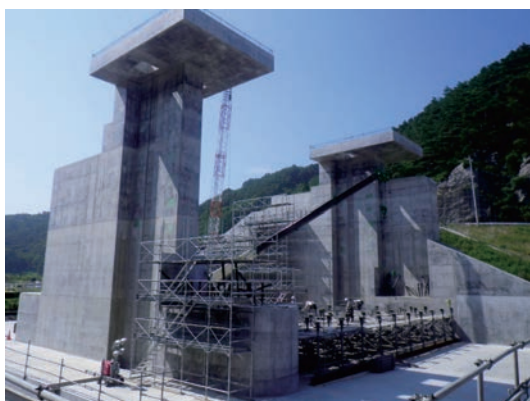
写真-12 カーテンウォール施工前
