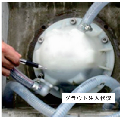
写真-9 高密度ポリエチレン製グラウトキャップ
