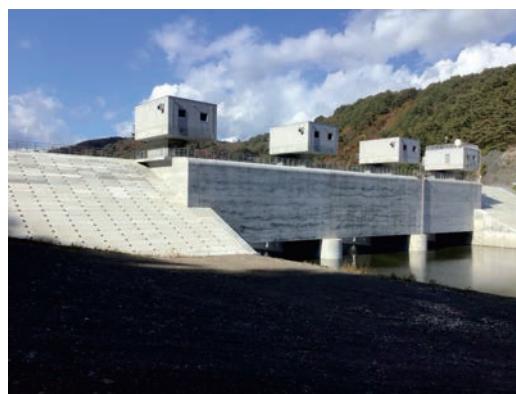
写真-1 海側全景
