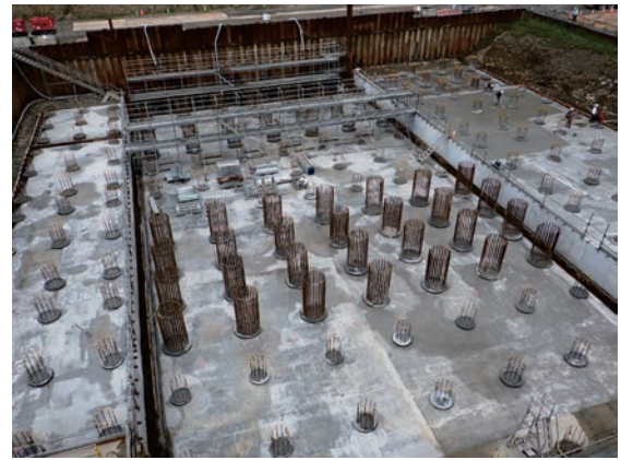
写真-7 杭施工後
