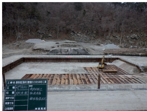
写真-4 仮締切（2期施工）
