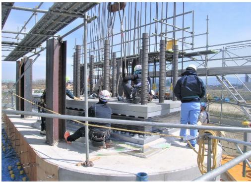
写真-4 支承据付状況
