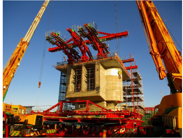
写真-6 P3橋脚部施工状況(2室箱桁構造)
