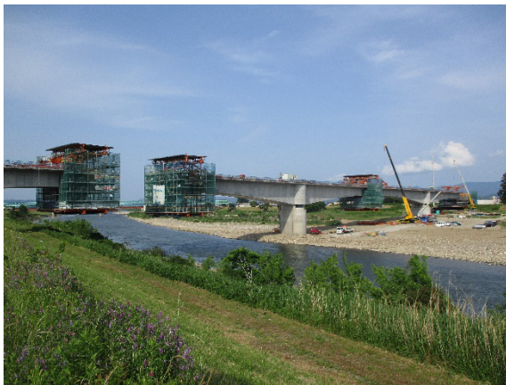
写真-8 張出し施工状況
