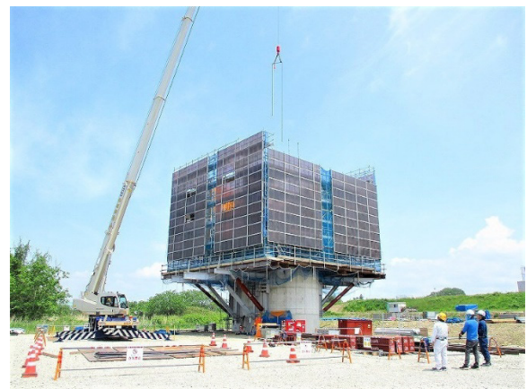
写真-2 柱頭部（ブラケット支保工）施工状況
