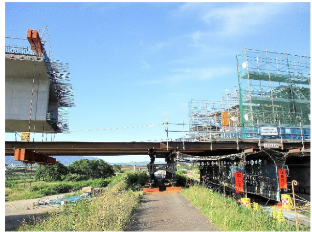
写真-10 A1 側径間施工状況
