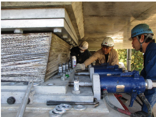
写真-5 支承ポストスライド状況
