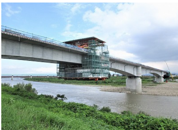
写真-9 中央閉合施工状況
