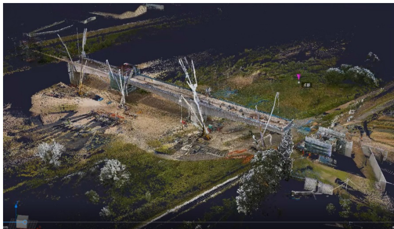
写真-13 橋梁全体の3次元点群データ画像
