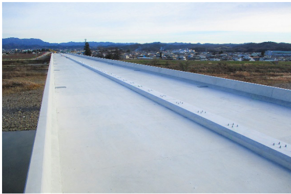
写真-1 橋面工（壁高欄施工完了）
