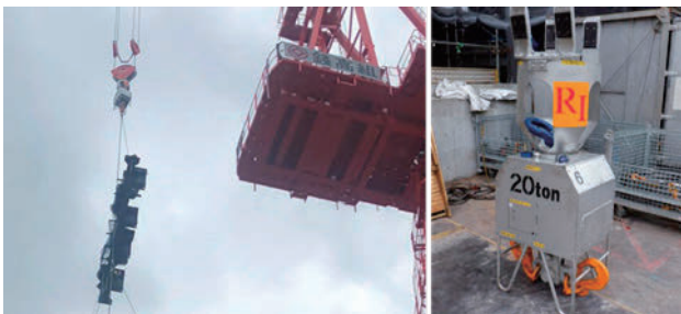
写真-3 無線操作式回転誘導装置「にくる」
