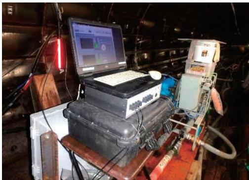
写真-9 充填検知システムによる計測状況
