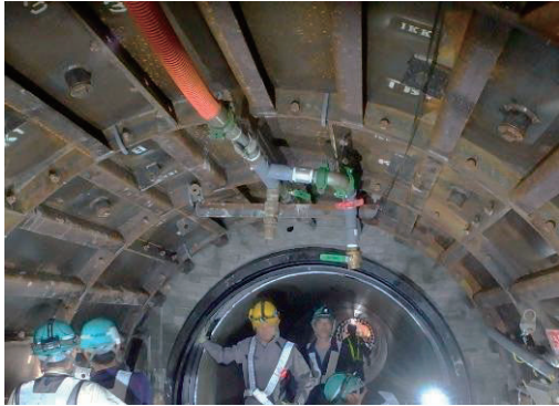
写真-8 エアームタル注入状況
