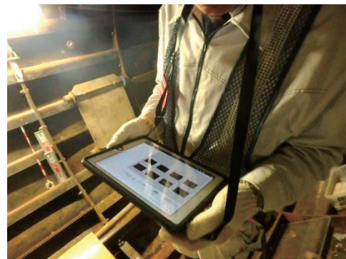
写真-11 タブレット端末による遠隔監視
