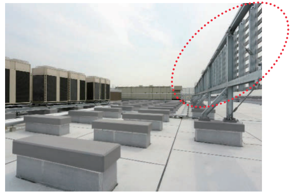
写真-2 屋上目隠し壁の設置例
