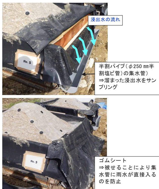
写真-1 浸出水集水管とゴムシートによる養生
