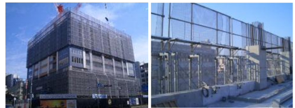
写真-12 連層足場
