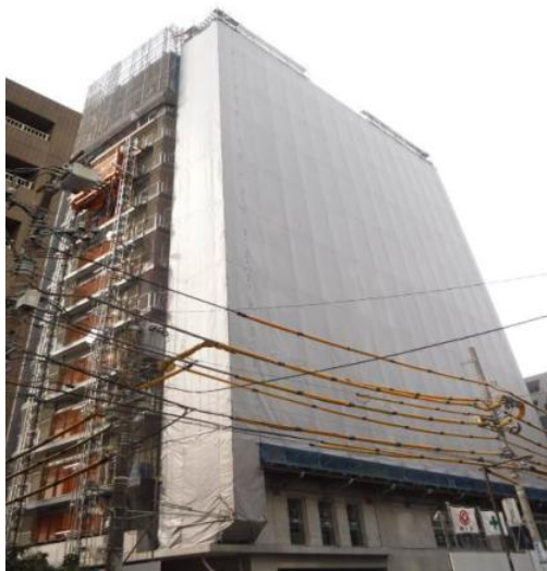
写真-11 仮設エレベータ設置状況
