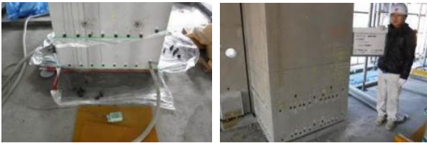
写真-21 グラウト注入状況、注入完了確認
