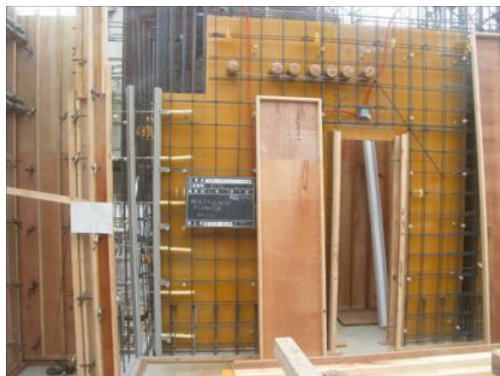
写真-15 柱・壁型枠
