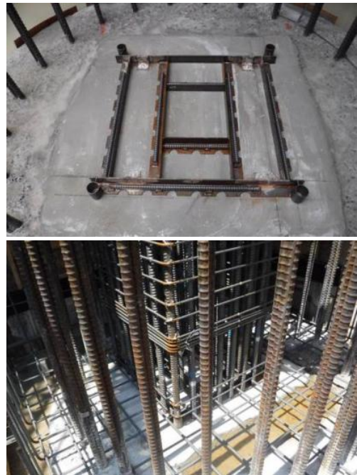
写真-18 柱主筋調整用治具（杭頭部に設置）
