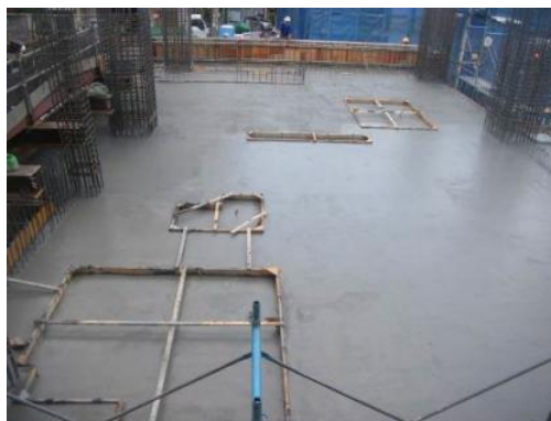
写真-17 コンクリート打設
