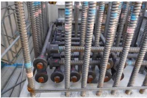
写真-9 梁主筋端部定着プレート
