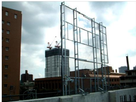
写真-13 養生足場
