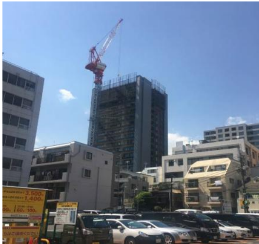
写真-10 北東面外観（17階躯体施工時点）
