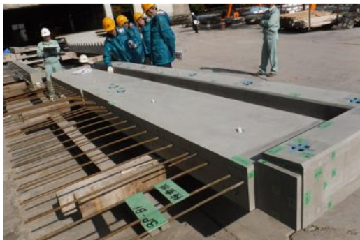
写真-5 バルコニー（工場検査時）
