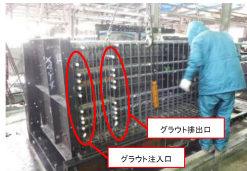
写真-6 柱主筋スリーブ継手
