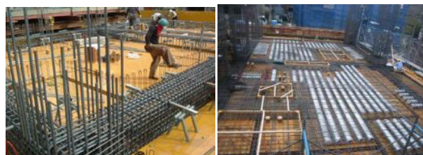
写真-16 梁配筋→スラブ配筋
