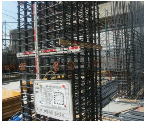
写真-14 柱・壁配筋（圧接工事含む）
