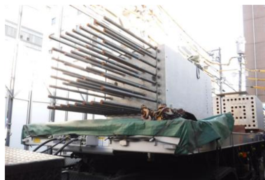
写真-1 PCa 柱（搬入状況）
