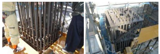
写真-20 柱主筋調整用治具（PCa 柱直下階に設置）
