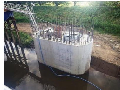
写真-6 ケーソン沈設完了状況
