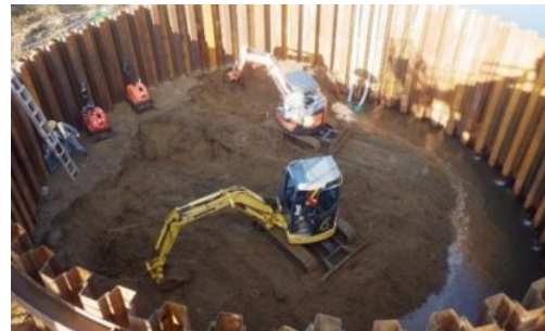
写真-2 築島工地盤鋤取り状況
