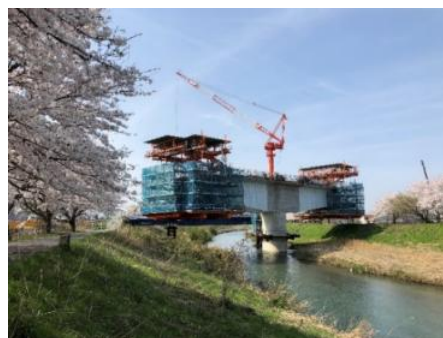
写真-19 張出架設 施工状況
