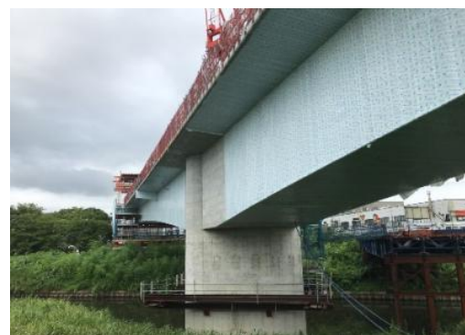
写真-13 張出架設時の保水養生テープ設置
