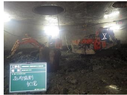
写真-4 函内掘削状況 (バックホウ 2 台)
