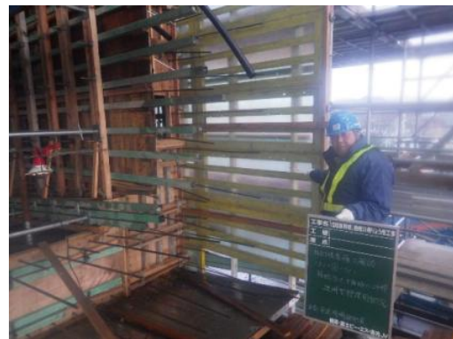
写真-11 透明型枠
