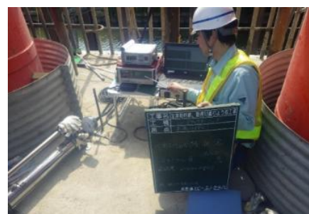
写真-7 地耐力試験の遠隔操作 (遠隔操作)
