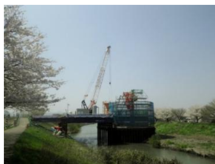
写真-18 ニューマチックケーソン施工状況
