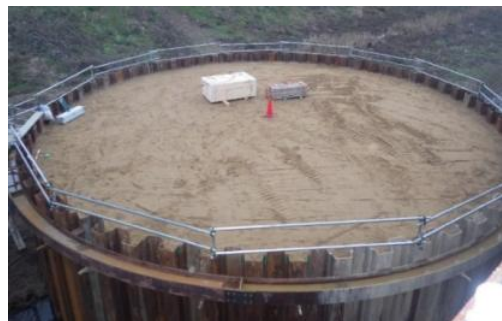
写真-3 築島盛土施工完了
