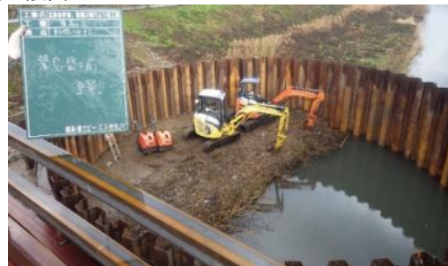
写真-1 ケーソン基礎構築箇所状況
