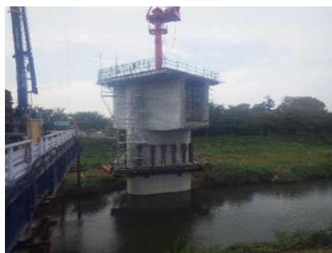
写真-9 柱頭部施工完了全景
