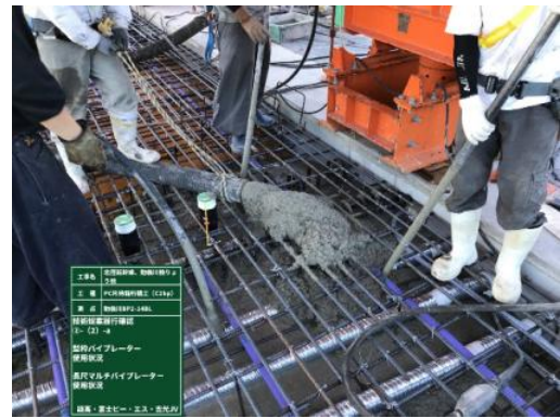
写真-10 φ31mm の長尺マルチバイブレーター
