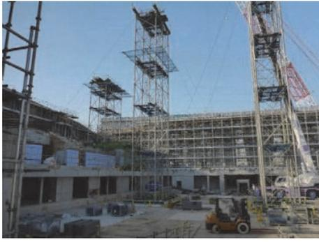
写真-6 アーチ鉄骨用ペント支柱の組立状況
