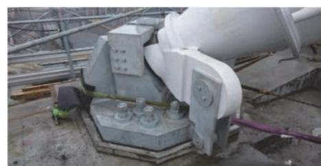
写真-4 ピボット支承(施工中の状況)
