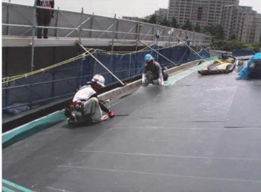
写真-19 アスファルトルーフィング施工状況
