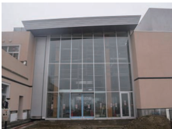
写真-8 足場解体後
