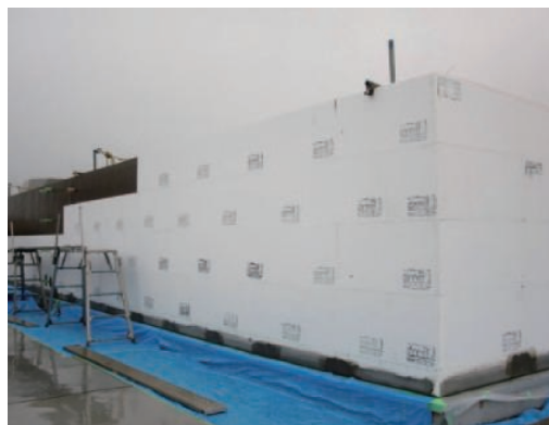
写真-9 EPS断熱材貼付け状況
