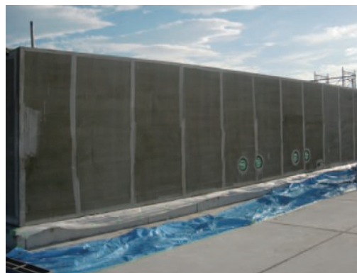
写真-10 メッシュ材貼付け状況
