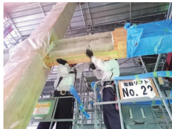
写真-6 接合部カバー材組み立て状況
