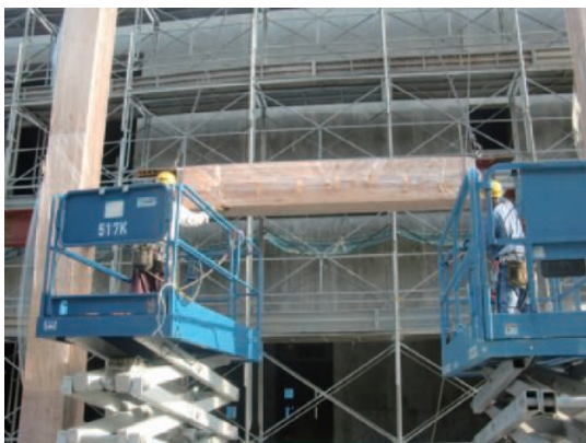
写真-5 梁架設状況
