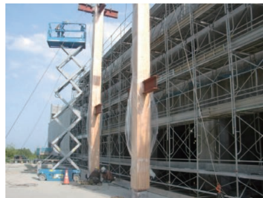
写真-4 柱建込状況
