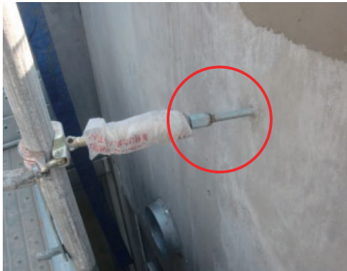
写真-12 躯体工事中
