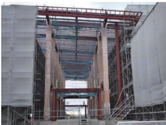
写真-7 建方完了状況
