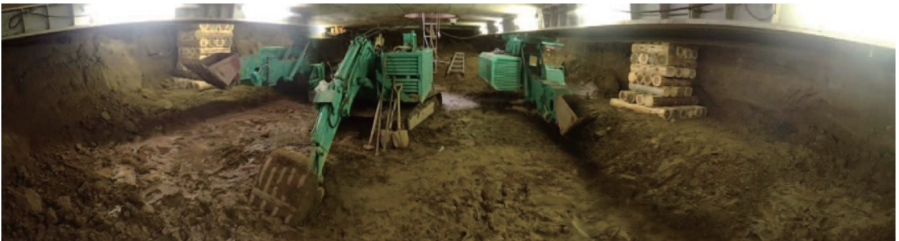
写真-5 函内掘削状況
