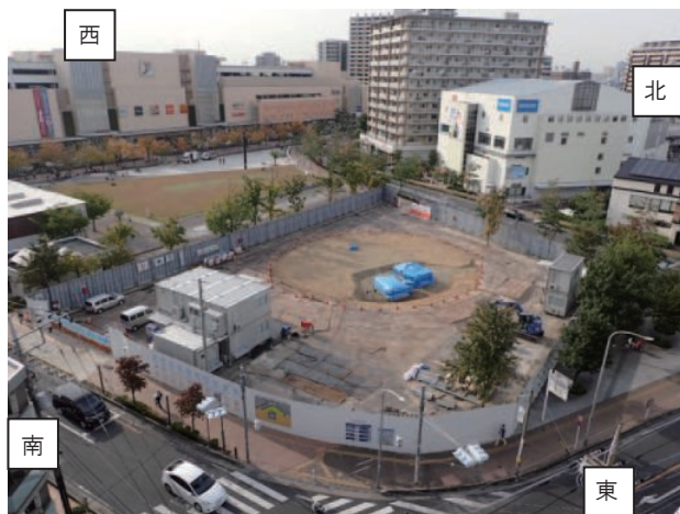
写真-9 施工全景 (沈設完了)
