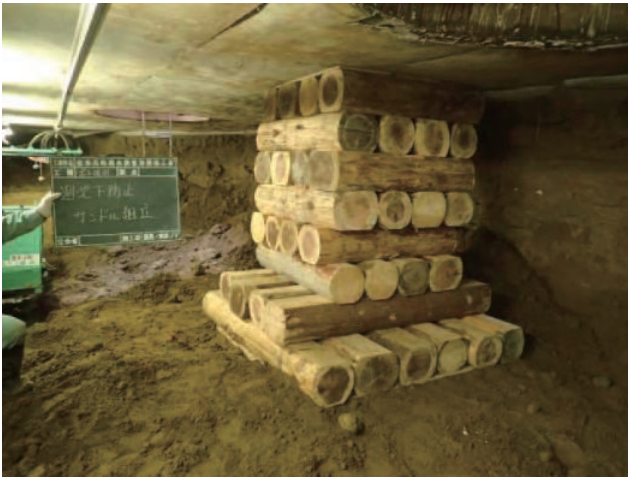
写真-3 サンドル設置状況
