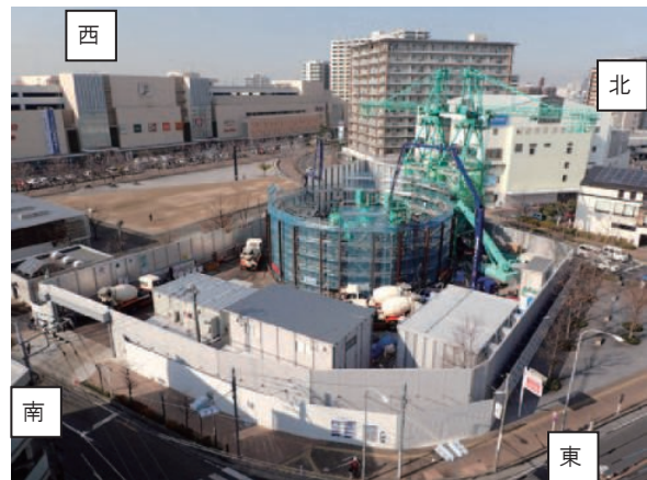
写真-1 施工全景
