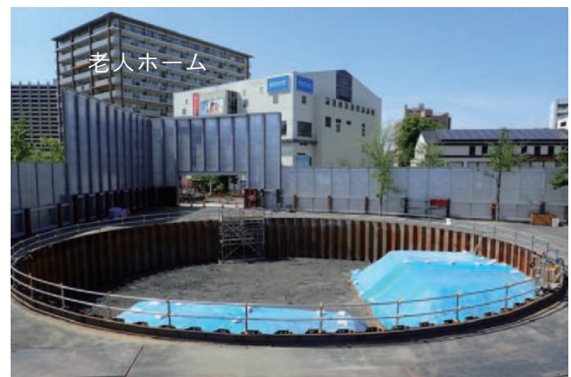
写真-2 防音壁設置状況
