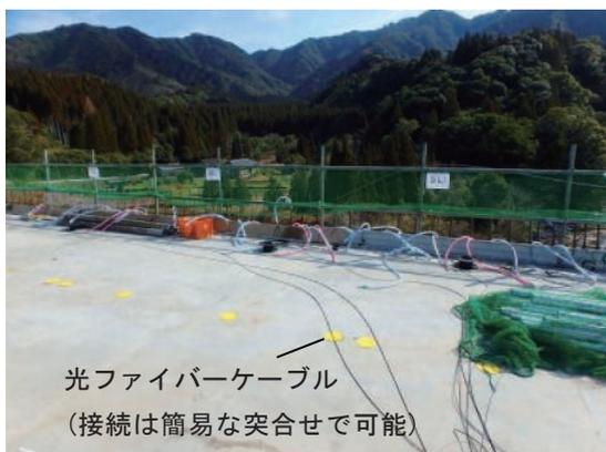
写真-15 グラウト充填検知センサーの延長
