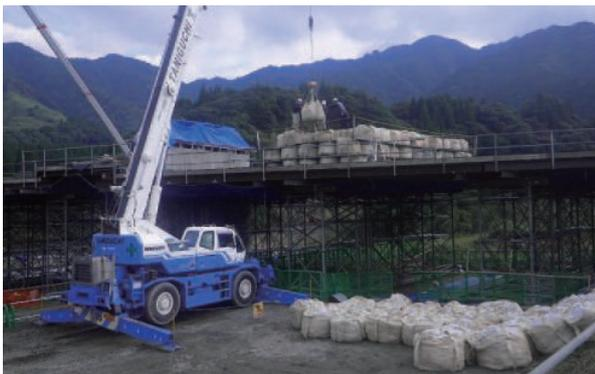
写真-7 支保工への実荷重載荷試験状況
