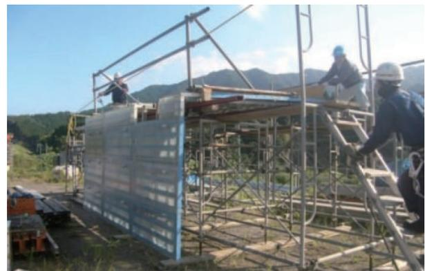
写真-3 型枠スライド方式の試験施工
