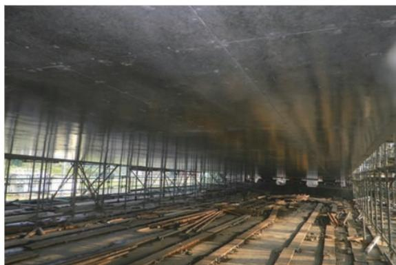
写真-11 固定支保工解体時の主桁下面状況
