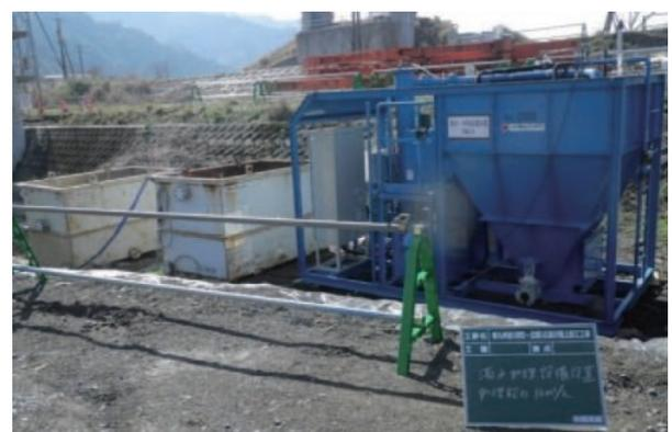
写真-5 濁水処理設備
