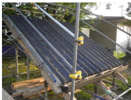
写真-3 モックアップ：屋根施工状況
