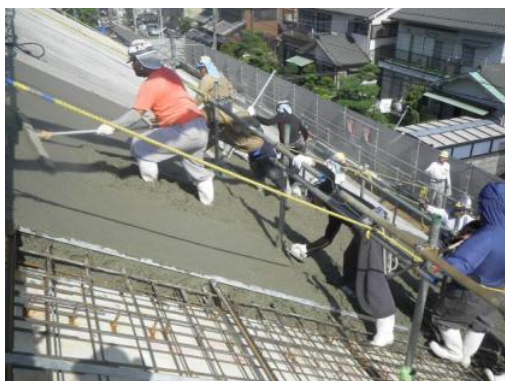
写真-8 S=13cm程度でのコンクリート打設状況
