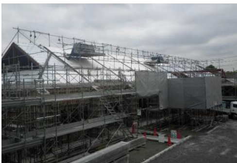
写真-5 屋根フラットデッキ+断熱材
