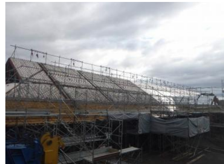
写真-7 スラブ配筋セット状況
