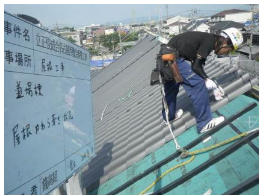
写真-10 かわら葺きビス固定状況
