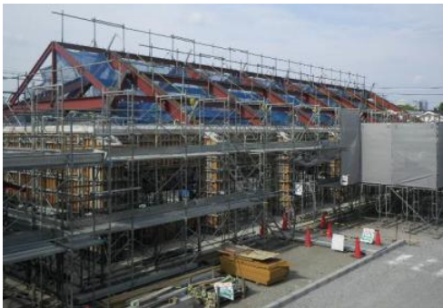
写真-4 鉄骨建て方・本締め完了
