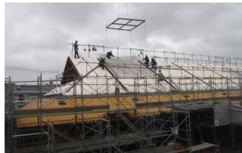
写真-6 スラブ配筋ユニット上架状況 （配筋ユニット上架時は仮設手摺を合番にて解体、復旧）
