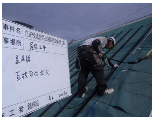
写真-9 かわら棒取り付け状況
