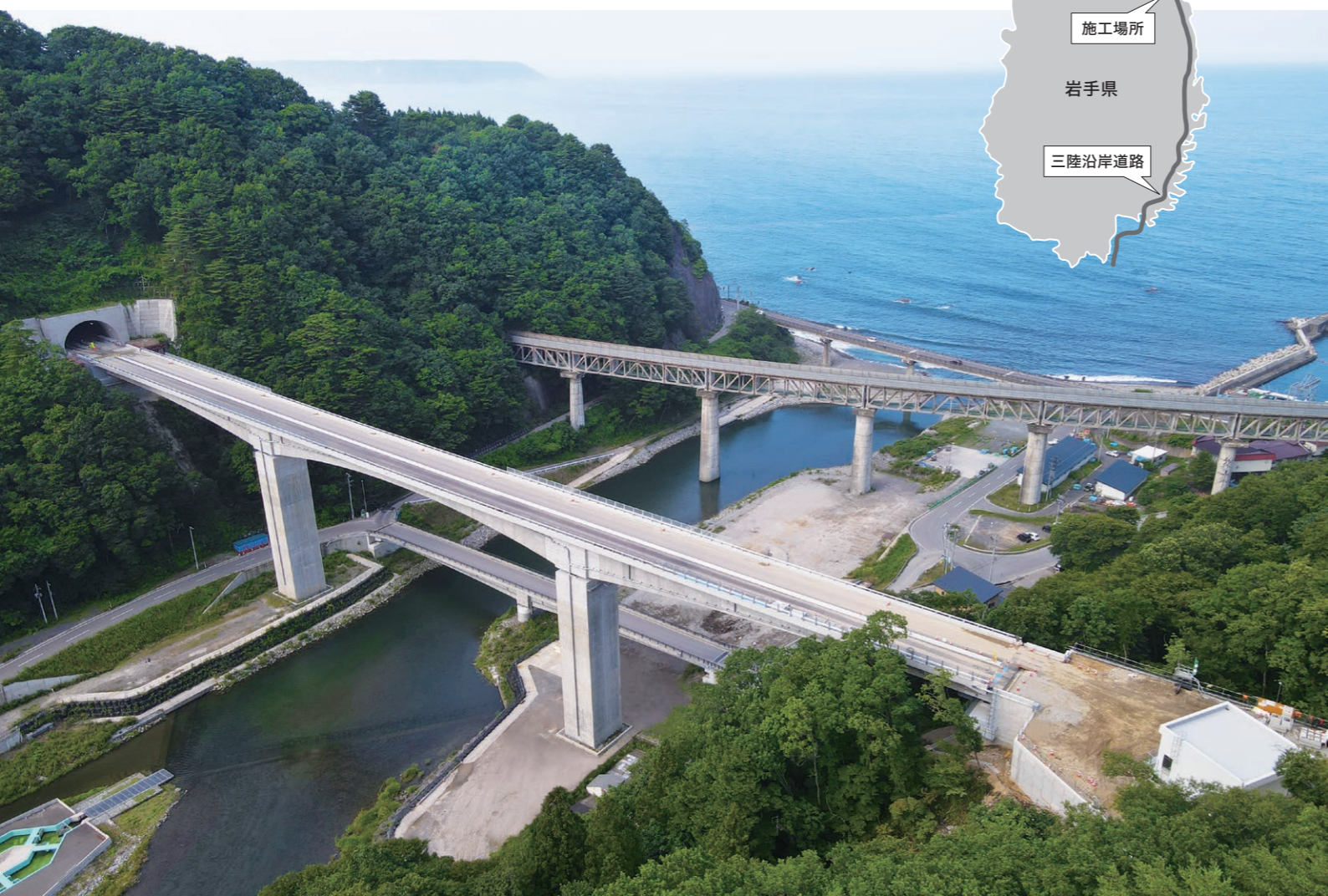
橋梁全景 手前が下安家大橋、奥は三陸鉄道の安家川橋梁
