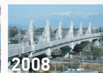
2008 東北新幹線三内丸山架道橋
