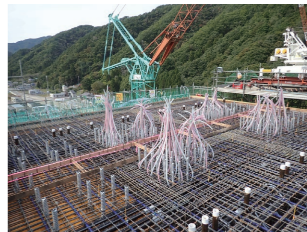
鉄筋と後施工用注入用ホース
