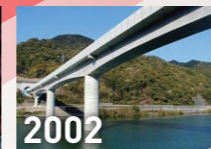
2002 九州新幹線 球磨川橋梁
