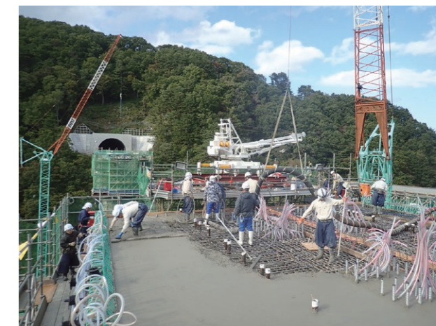
コンクリート打設
