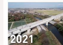
2021 北陸新幹線 動橋川橋梁
