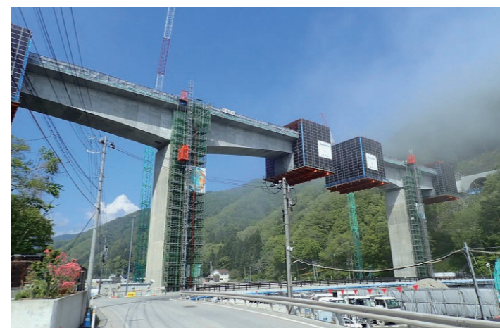
張出し架設中の橋梁と迫り来る「やませ」
