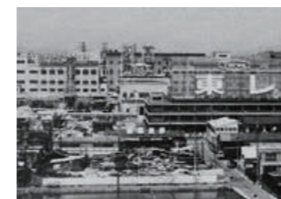
東洋レーヨン 三島工場(現・東レ 三島工場) (1957年より施工)
