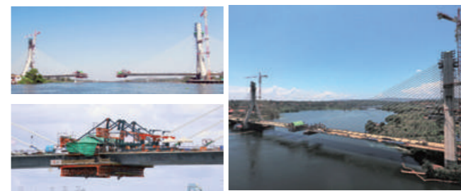
閉合直前のナイル川源流橋
