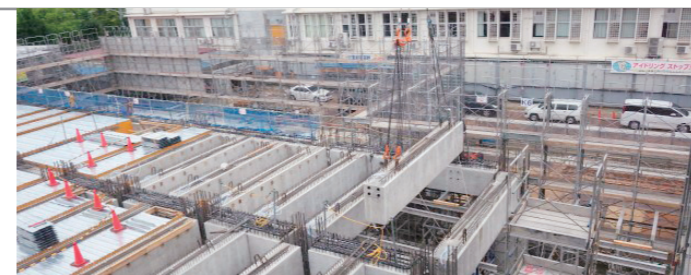
PCaPC梁の施工
