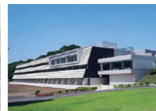
東レ 基礎研究センター(鎌倉) 先端融合研究所(2003年完成)
