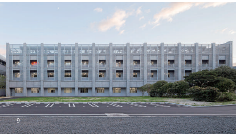
実証研究棟 北側外観
