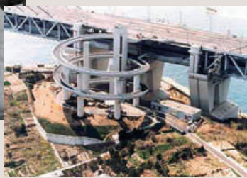
瀬戸大橋 櫃石島ループ橋
