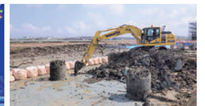
ICT建機による掘削状況
