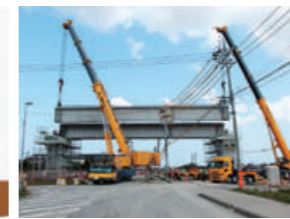
実際の桁架設状況
