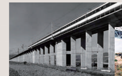
東海道新幹線 向日町高架
