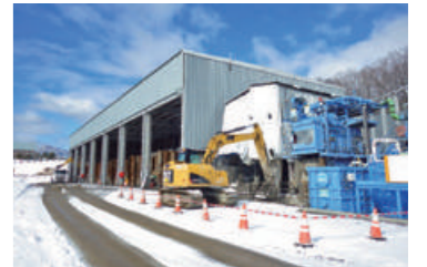
仮置き用土砂ピットと泥水処理プラント
