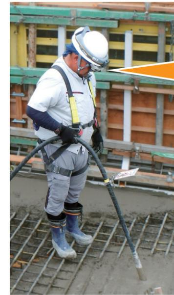
ヘッドマウントディスプレイを装着した作業員によるコンクリート締固め
