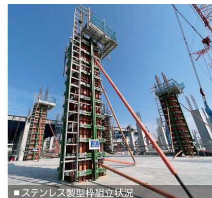
■ ステンレス製型枠組立状況
