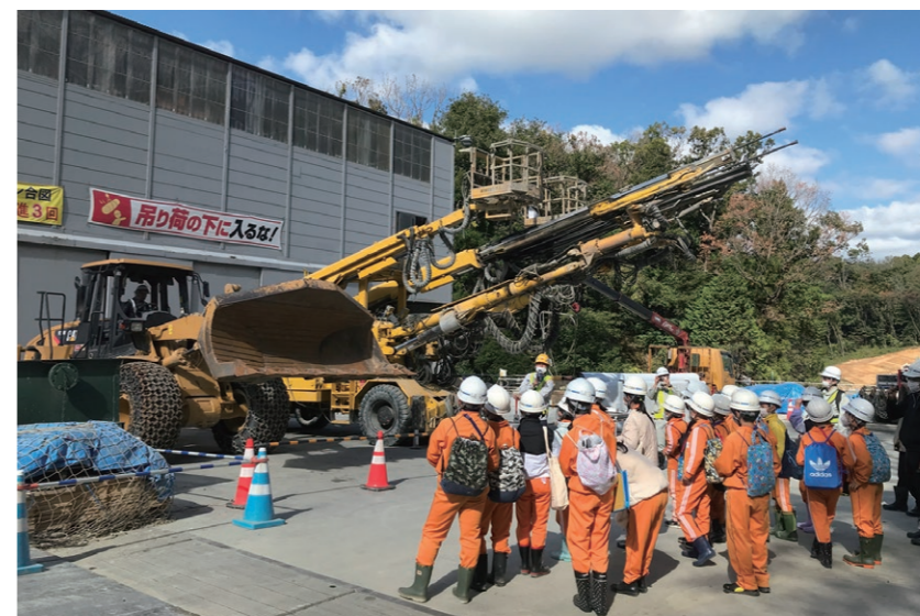
国道6号 勿来トンネル工事作業所(福島県)
