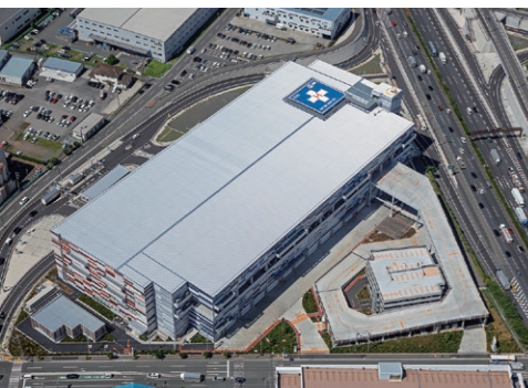
施設全景(空撮)
