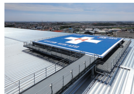
屋上に設置されたヘリポート
