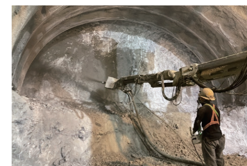
コンクリートの一次吹付作業 吹付コンクリートに回収したCO 2 を再利用する計画
