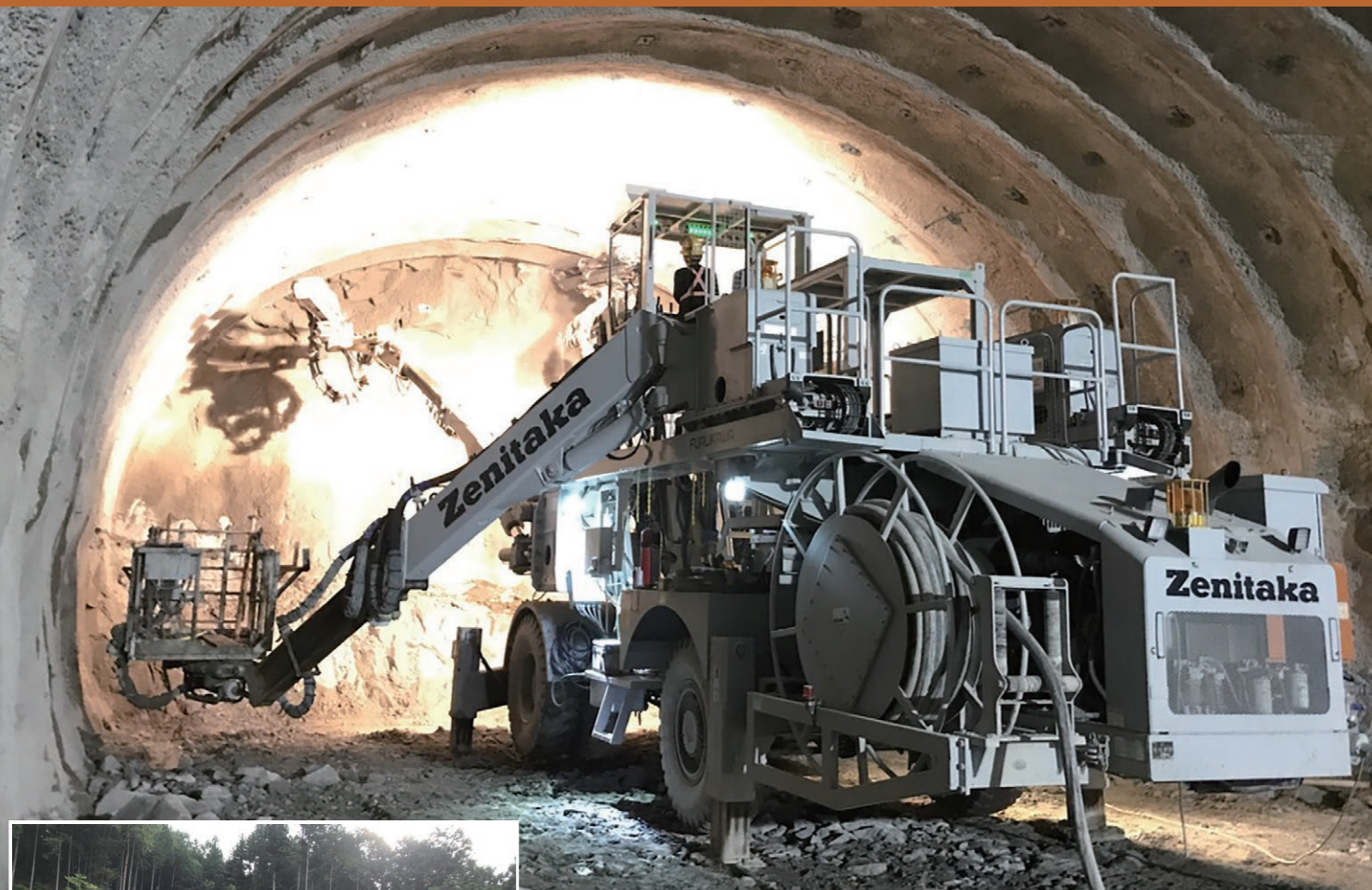
削孔作業 「ドリルジャンボ」という重機によりダイナマイトを入れる穴を掘る
