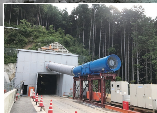
坑口部分 発破用の防音扉の上部から伸びる換気ファン
