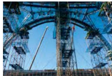
屋内から見たアーチ鉄骨用ベント支柱
