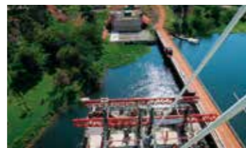
A1橋台~P1張出し全景
