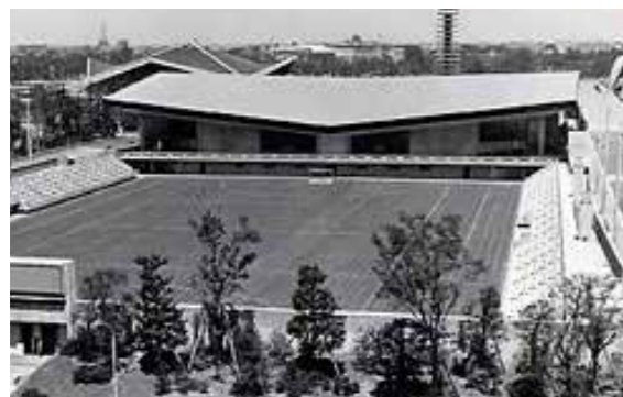
旧駒沢オリンピック公園総合運動場 屋内球技場・第一球技場 (施工:銭高組) 1964年9月完成時の写真
