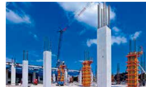
柱型枠にシステム型枠を採用
