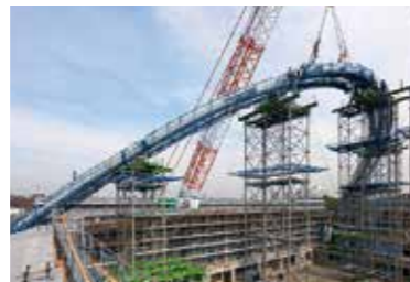
アーチ鉄骨組立状況
