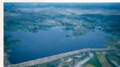
フィリピン西部バリオス灌漑ダム工事
