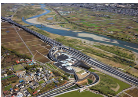
首都圏中央連絡自動車道 関口高架橋
