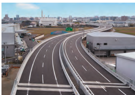
首都圏中央連絡自動車道 金田高架橋
