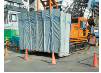
防音シートの設置
