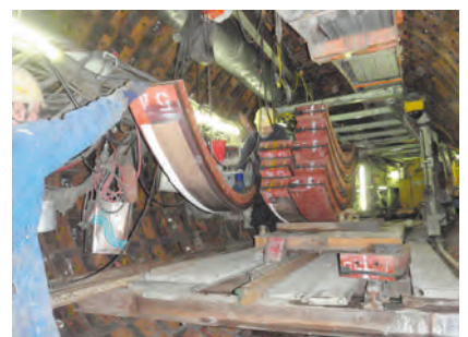
セグメント取り付け状況
