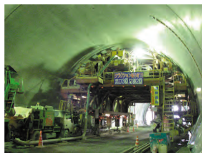
覆工コンクリート打設状況
