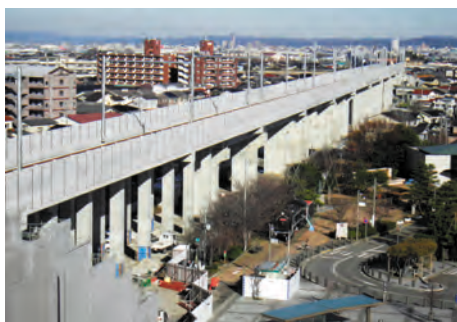
北陸新幹線 松任高架橋
