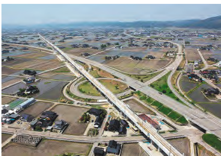
北陸新幹線 開ほつ高架橋
