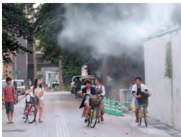
ミストシャワーを設置した仮囲い
