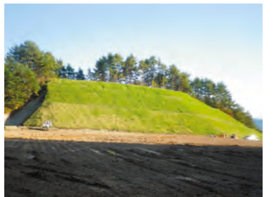
緑化工事施工後
