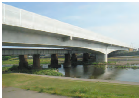
北陸新幹線 加賀犀川橋りょう
