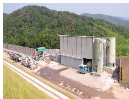
バッチャープラント
