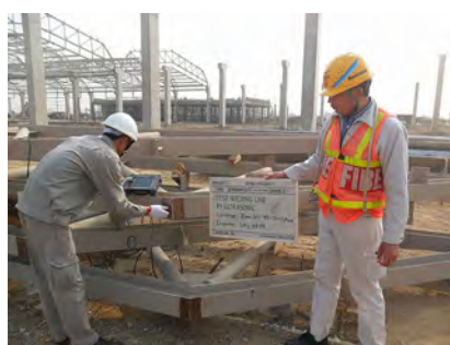
鉄骨超音波検査
