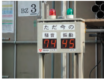
騒音・振動計の設置
