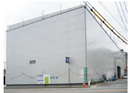
発進立坑防音設備
