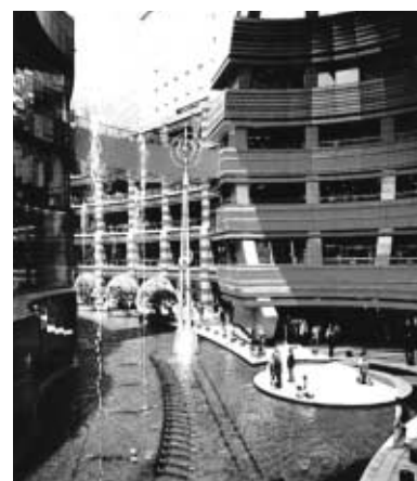
キャナルシティ博多(当社施工)
