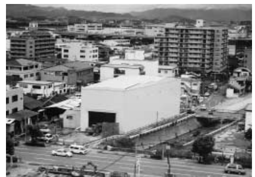
防音ハウス設置状況
