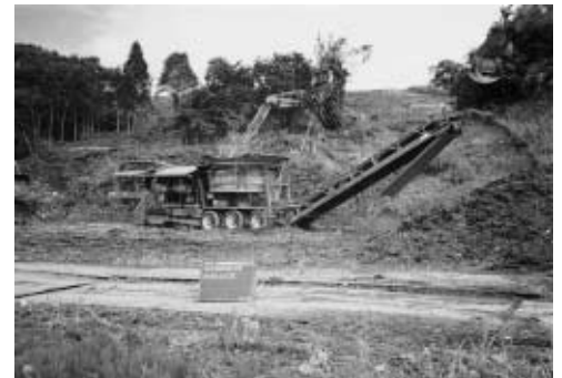
伐根・伐採材チップ処理状況
