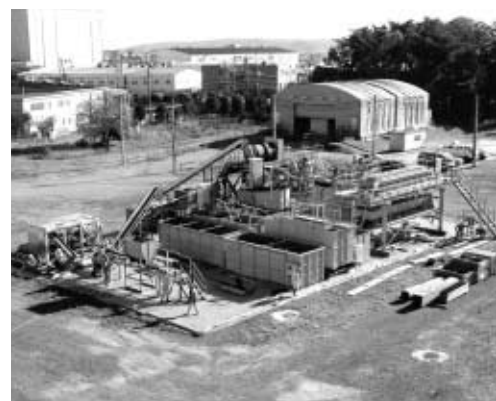
土壌洗浄法（スパイラル・ソイルウォッシャー） 実証実験状況（当社技術研究所）
