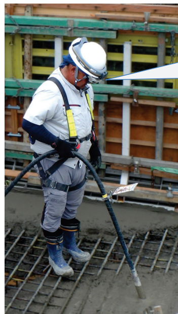
ヘッドマウントディスプレイを装着した作業員によるコンクリート締固め
