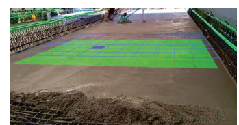
締固め完了状況
